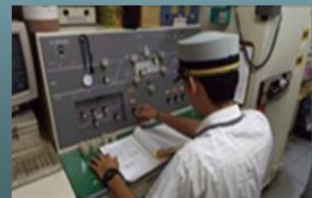
連動制御盤取扱い訓練
