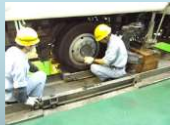
車両（搬送台車設置）
